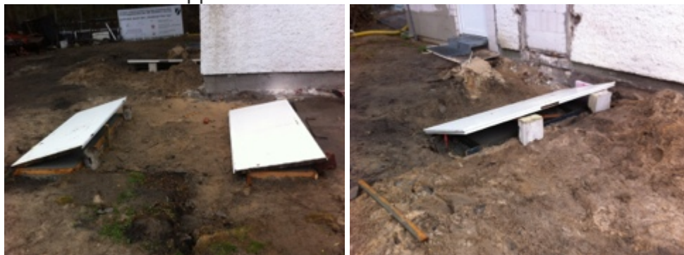
Fundament Nottreppe nachher
