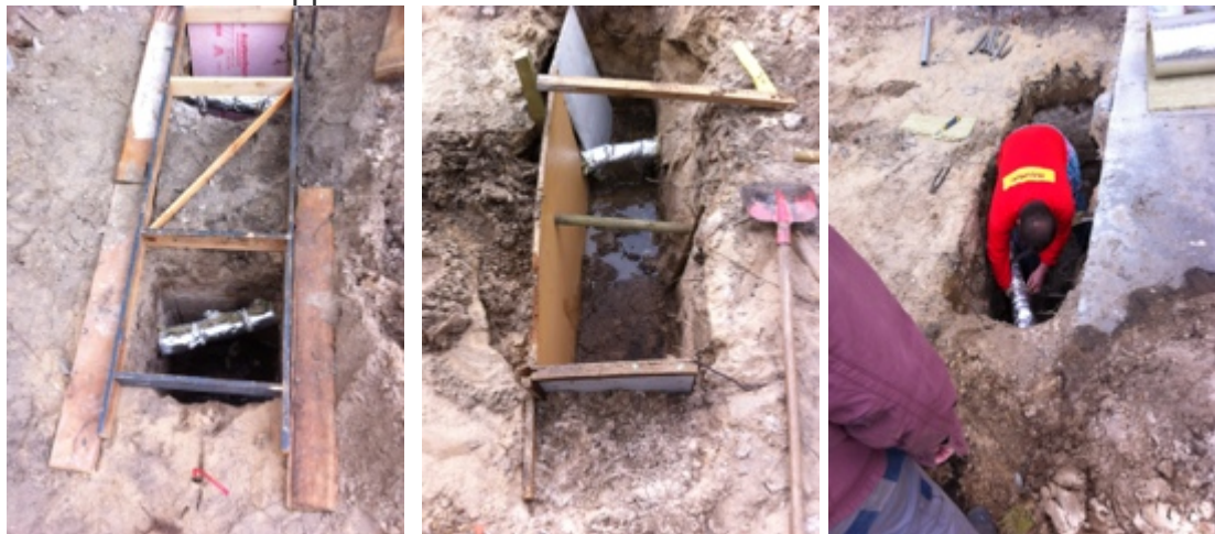
Fundament Nottreppe vorher
